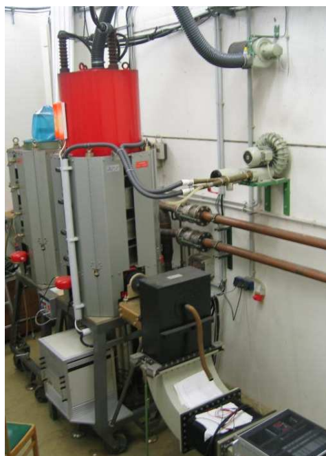
Abbildung 3.5: 300 kW-Klystron mit abgehendem rechteckigem Hohlleiter zum Transport der 500 MHz-Hochfrequenz zu den PETRA-Resonatoren im ELSA-Stretcherring.
