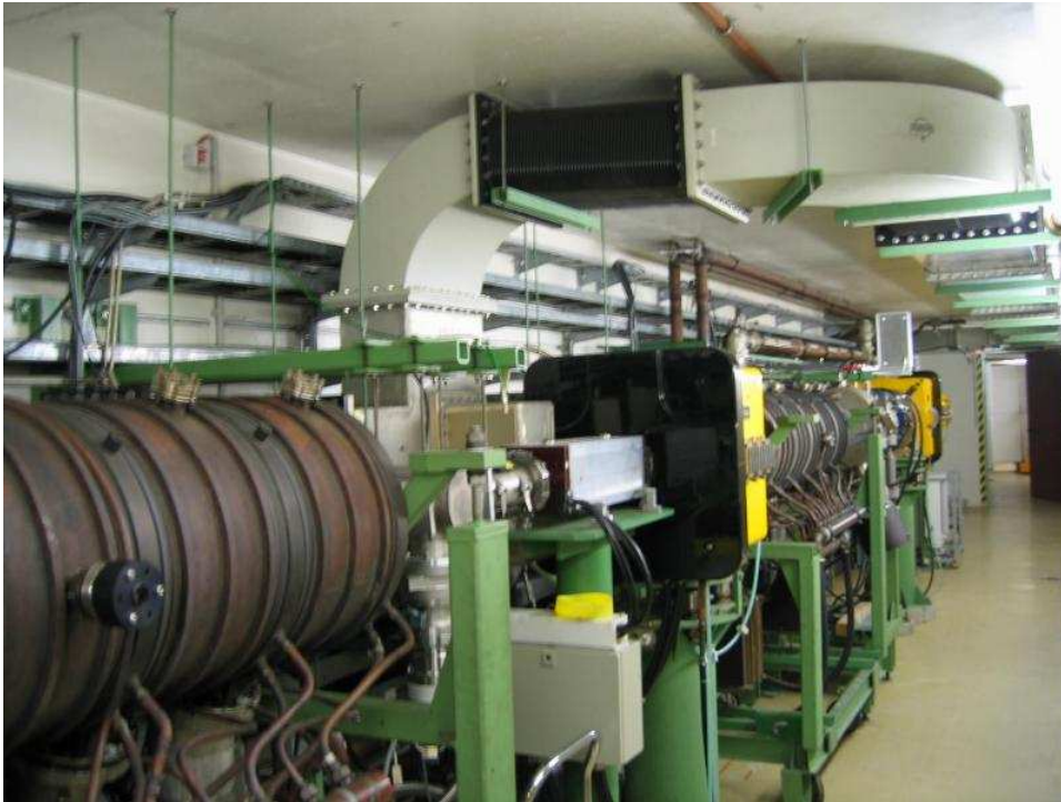
Abbildung 3.1: PETRA-Resonatoren 1 und 2 im Stretcherring der Universität Bonn, ELSA.
